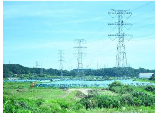
除染土が野積みになっている原発周辺
