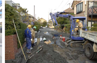
浦安市建設協力会による 下水管の応急復旧作業
