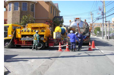
東京都下水道局による 下水管内の土砂除去作業
