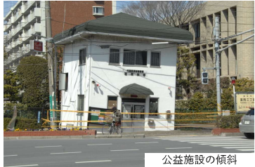
公益施設の傾斜
