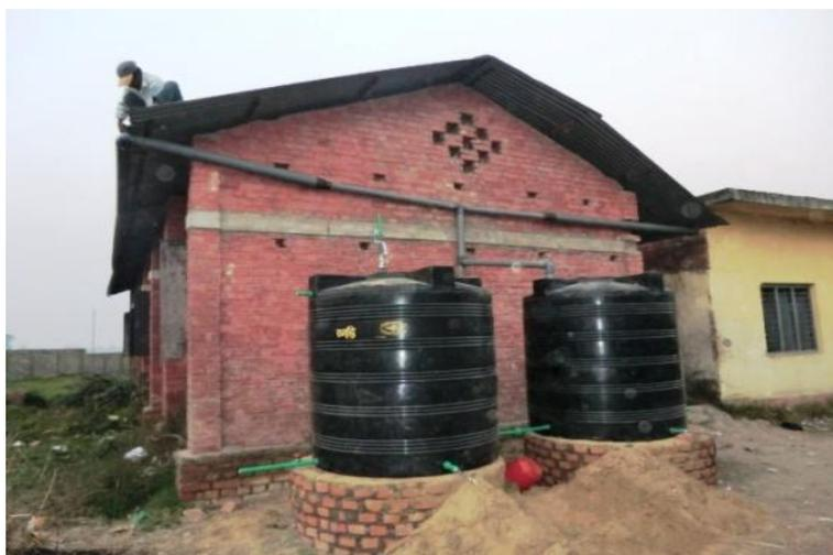
写真 4. 小学校の校舎に設置された雨水利用装置
