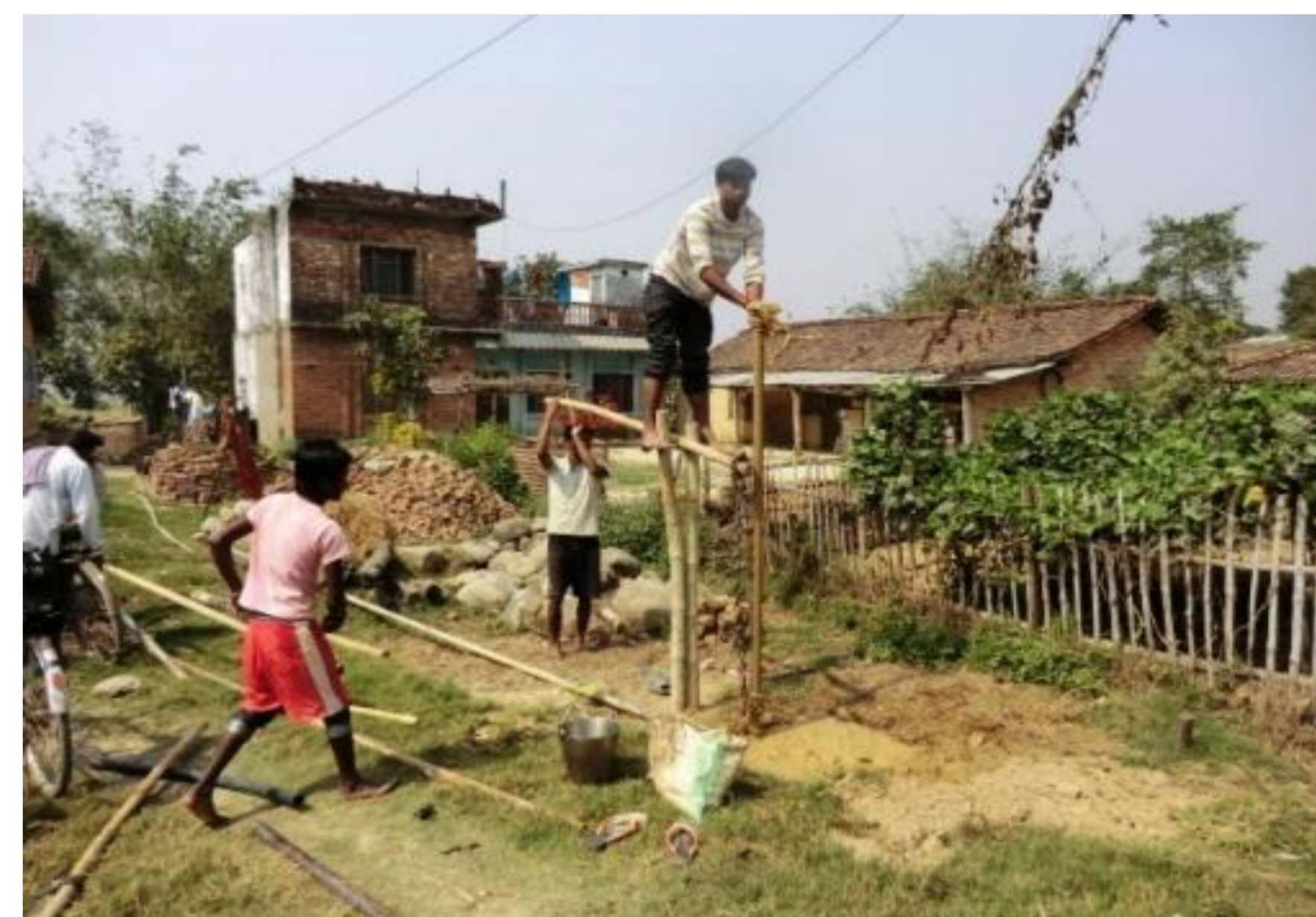
写真3. 井戸掘削の現状
